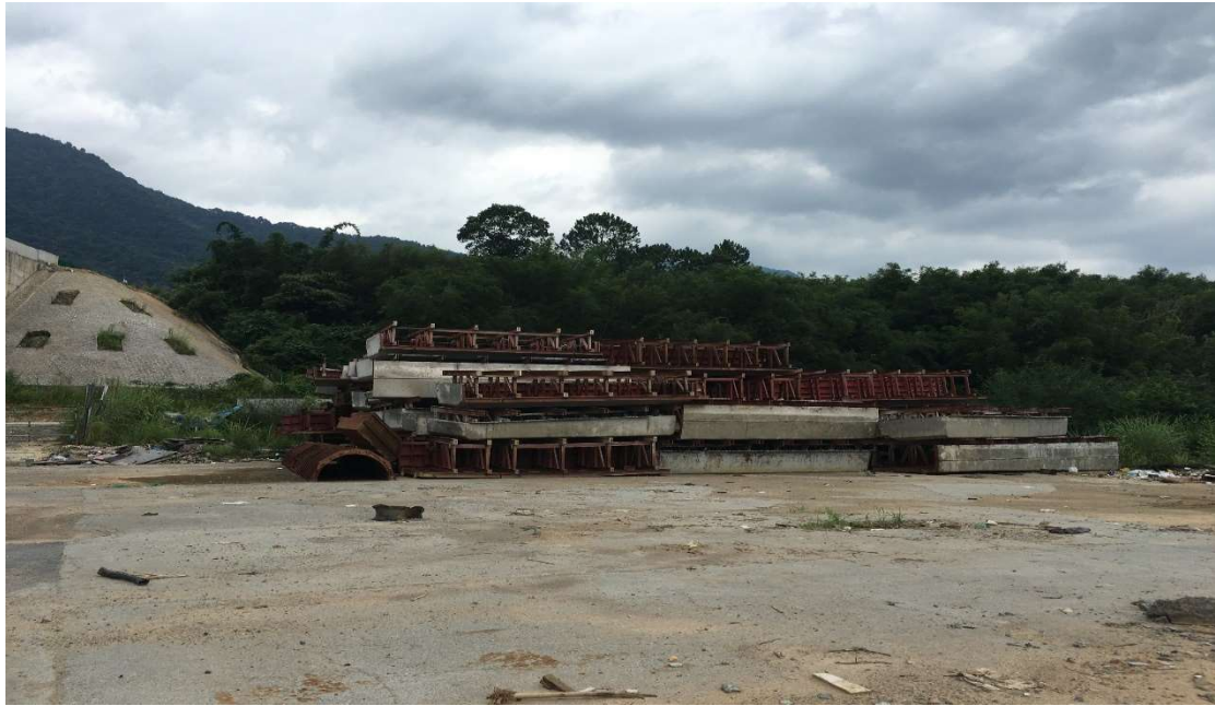
1#废旧模板 T 梁模板、存放地点：昭平县（图 1）
